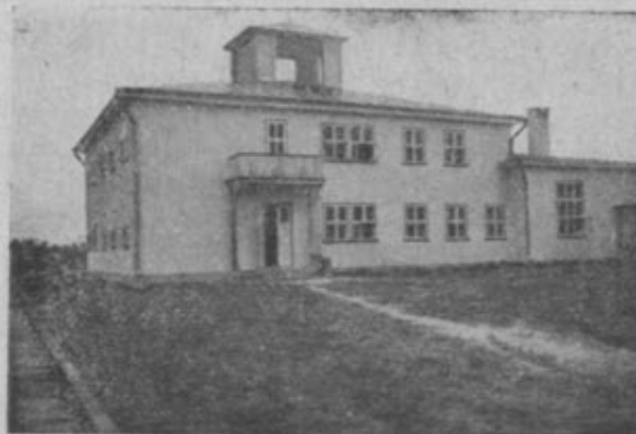
Dom turystyczny P. T. K. nad jez. Wigry (pow. Suwałki).
